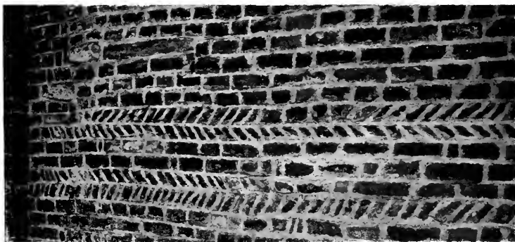
Fig. 340 — Struttura esterna dell'abside maggiore di Sant'Ambrogio a Milano (ca. 759-824)
